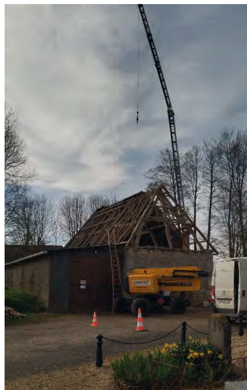
Restauration de l'atelier communal
